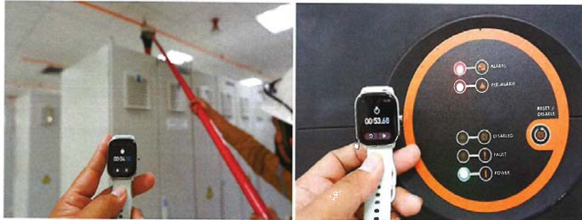
Test Alarm Pipe Line 3 ทดสอบได้เวลา 53.68 วินาที
