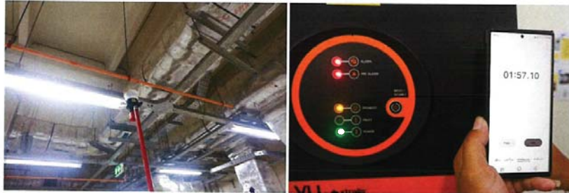
Test Alarm Pipe Line 3 ทดสอบได้เวลา 106.08 วินาที
