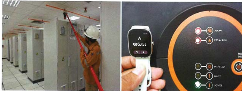
Test Alarm Pipe Line 4 ทดสอบได้เวลา 53.86 วินาที
