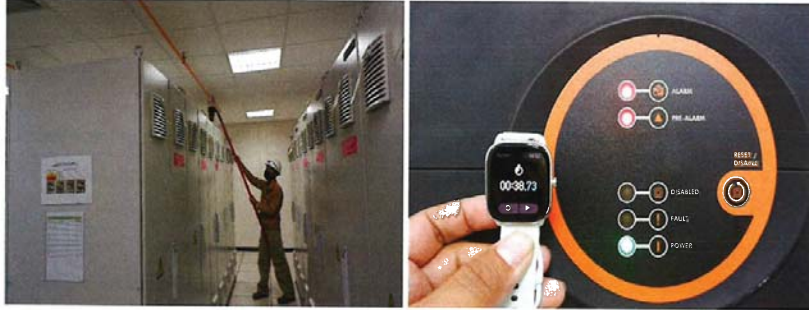
Test Alarm Pipe Line 2 ทดสอบได้เวลา 38.73 วินาที
