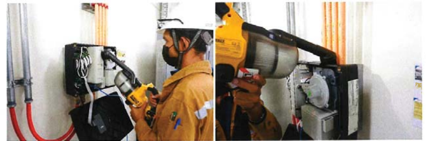
4.5 ทำความสะอาดอุปกรณ์และทำการดูแลตามรู Detector หลังการทดสอบระบบเสร็จสิ้น
