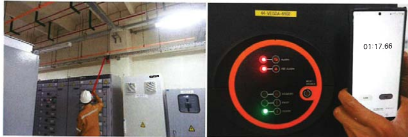
Test Alarm Pipe Line 4 ทดสอบได้เวลา 77.66 วินาที
