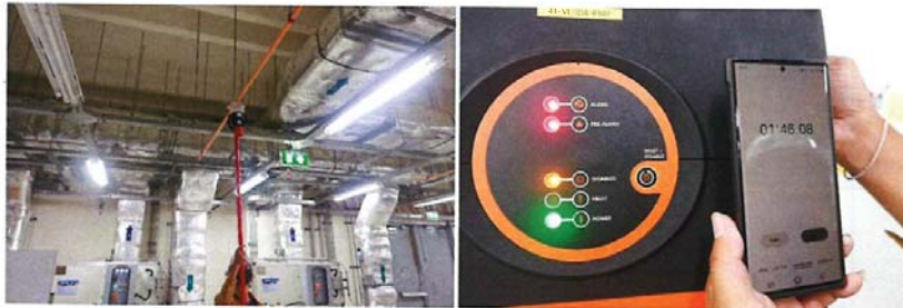
Test Alarm Pipe Line 3 ทดสอบได้เวลา 106.08 วินาที
