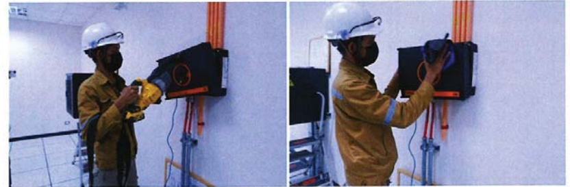
1.5 ทำความสะอาดอุปกรณ์และทำการดูดฝุ่นตามรู Detector หลังการทดสอบระบบเสร็จสิ้น
